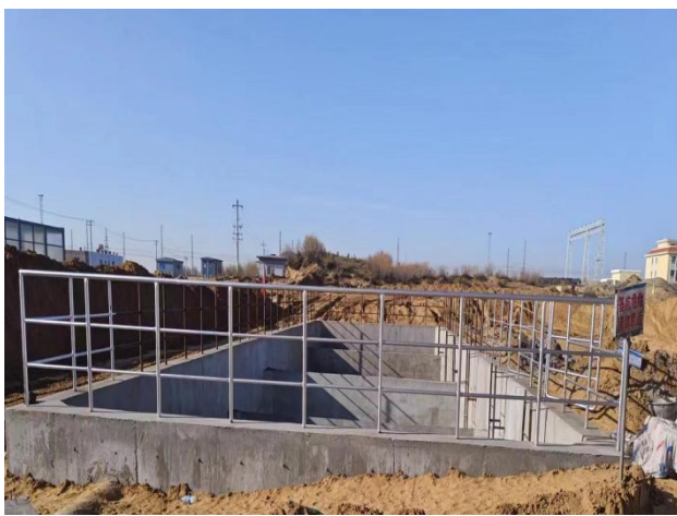
初期雨水收集池
