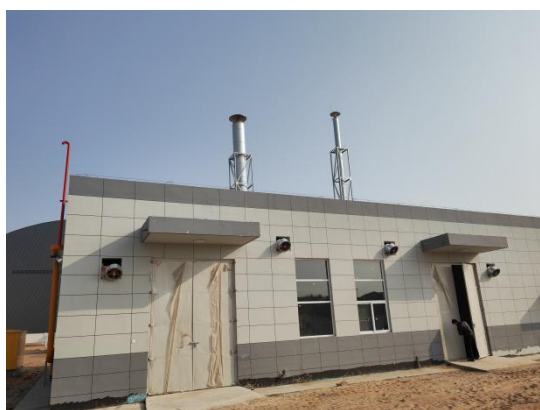
锅炉房烟囱（15m）
